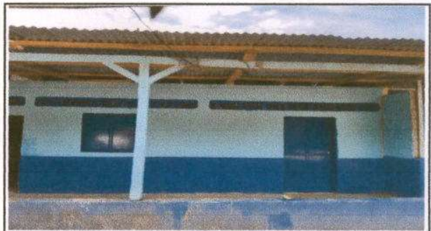
Foto 10: puerta y ventana nueva instalada
