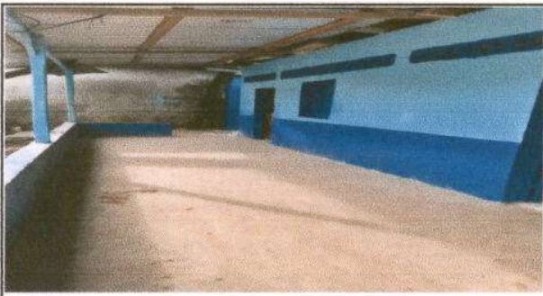
Foto 9: Nuevo piso en corredor
