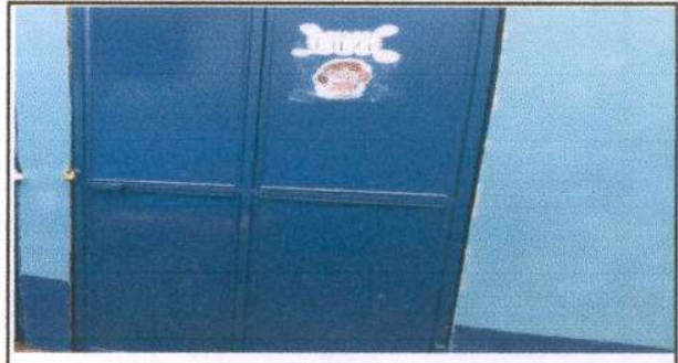
Foto 8: Instalación de sanitario para niñas con puerta de metal.
