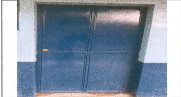
Foto 1: Nuevas puertas de metal
