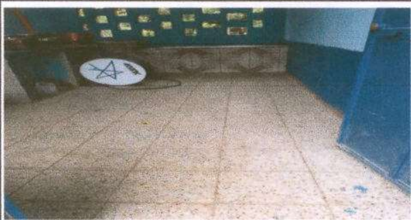
Foto 15: Piso de la cocina instalado piso de granito.
