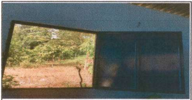
Foto 12: Ventanas nuevas instaladas
